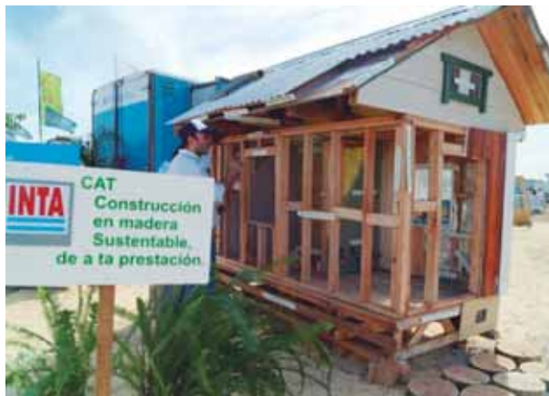
Pequeña casa de madera que INTA Concordia presentó en Expoagro 2017.
